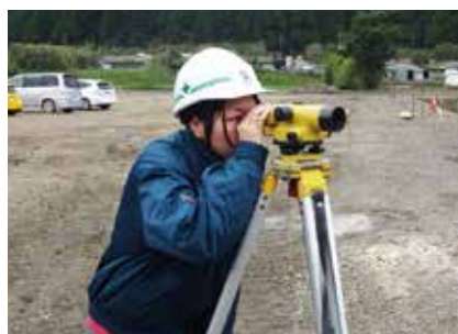
現場で測量作業を行う原田さん。先輩監督や下請業者ともコミュニケーションを取り円滑に仕事を進める
