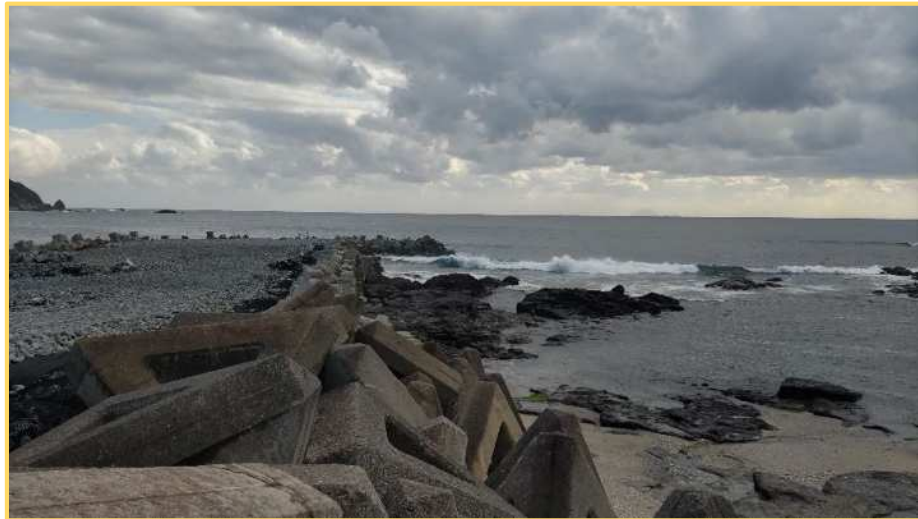
(監査人撮影：離岸堤への仮道)
