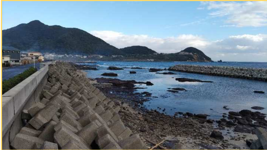
(監査人撮影：離岸堤有無による波の違い)
