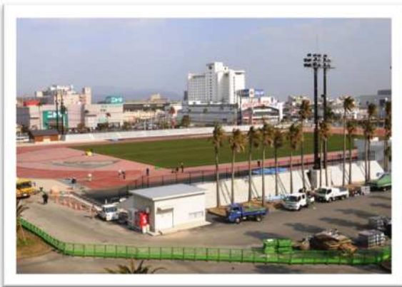
鴨池補助競技場(改修整備) (S26)
