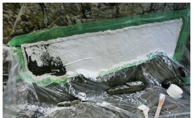
図 17 型取り状況 (シリコンの塗布)
