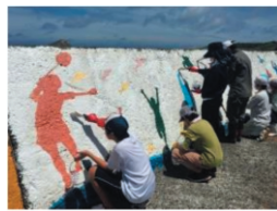
修復作業中の様子
