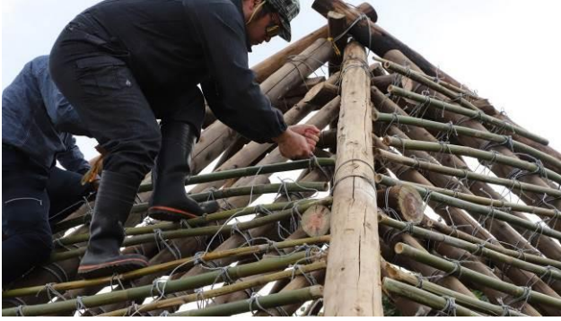
【サタ小屋屋根の葺き替えの様子】
