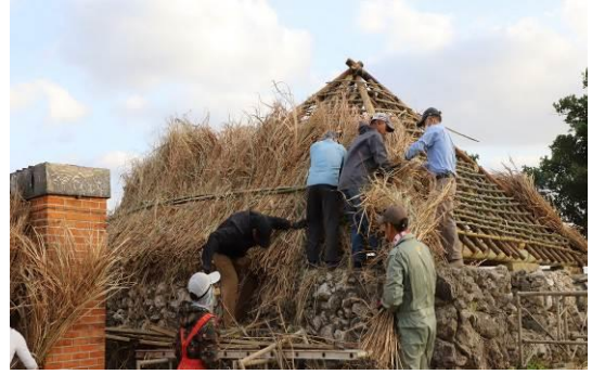
【サタ小屋屋根の葺き替えの様子】
