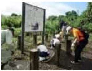
埋没門柱の清掃
