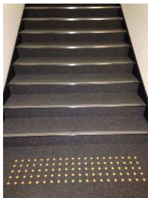
点字ブロック
