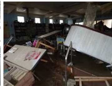
令和2年7月豪雨の被害
