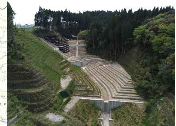
山地災害の復旧(完成) 溪間・山腹工
