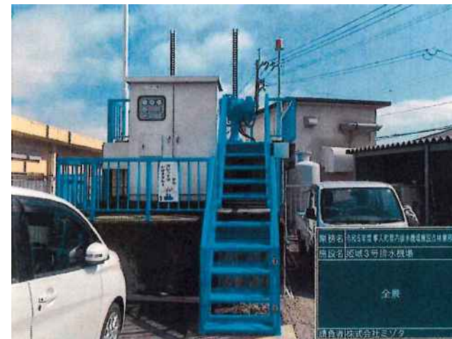
【排水機場等点検・維持管理】
