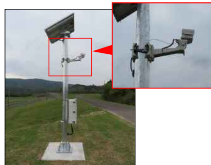
簡易型河川監視カメラ
