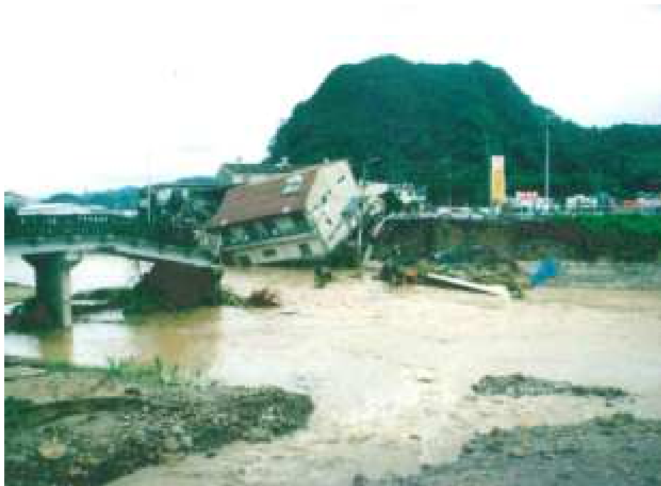
平成5年8月1日の集中豪雨 思川 城瀬橋
