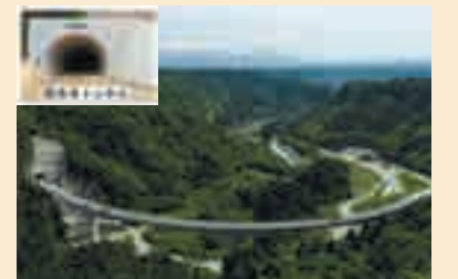
国道504号西光寺拡幅（施行中）
