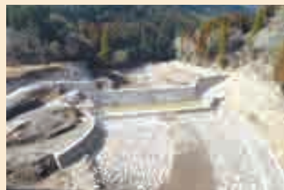
霧島川 11号えん堤（2023年3月完成予定）
