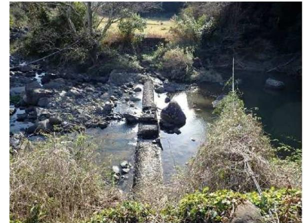
固定堰により取水を行っているが堰天端の摩耗により用水路への導水に支障をきたしているため堰改修いぜきの高上げを検討中。
