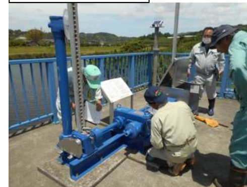
樋門操作講習会
