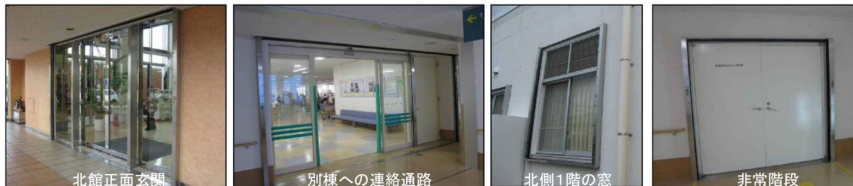
止水板のための角落としの設置
