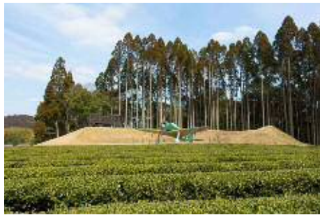
南九掩体壕全景008.jpg
