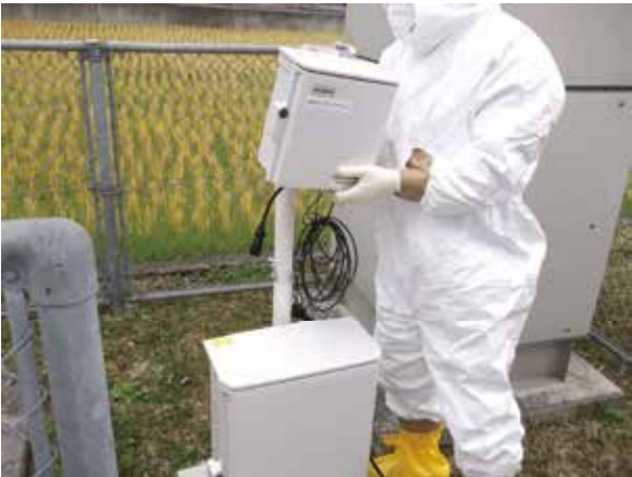
可搬型モニタリングポスト設置
