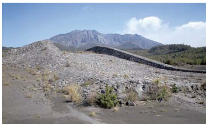
図 3-4-25 空石積み *6 による緩傾斜型落差工 *7 引ノ平川
