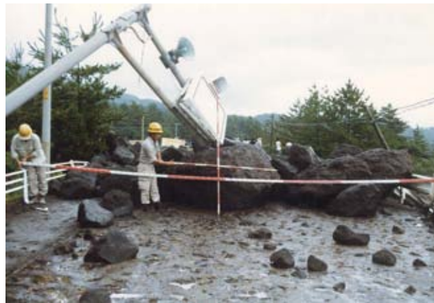
図 3-4-21 持木川の道路土砂堆積状況 (昭和 57 (1982) 年 7 月 24 日)
