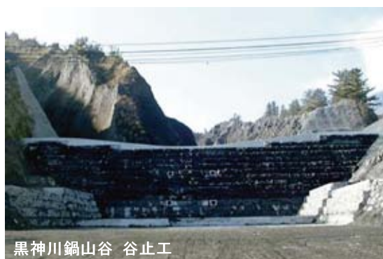
図 3-4-26 ISM (現位置攪拌混合固化) *8 工法による谷止工・堰堤
