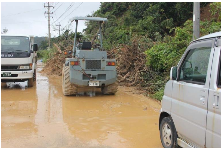
主要地方道龍郷奄美空港線崖崩れ
