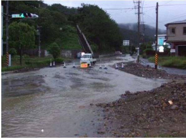
国道58号 奄美市名瀬浦上地内
