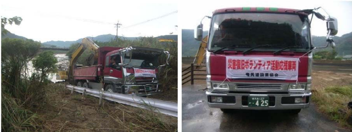
重機による河川堆積土砂の積み込み・搬出状況
