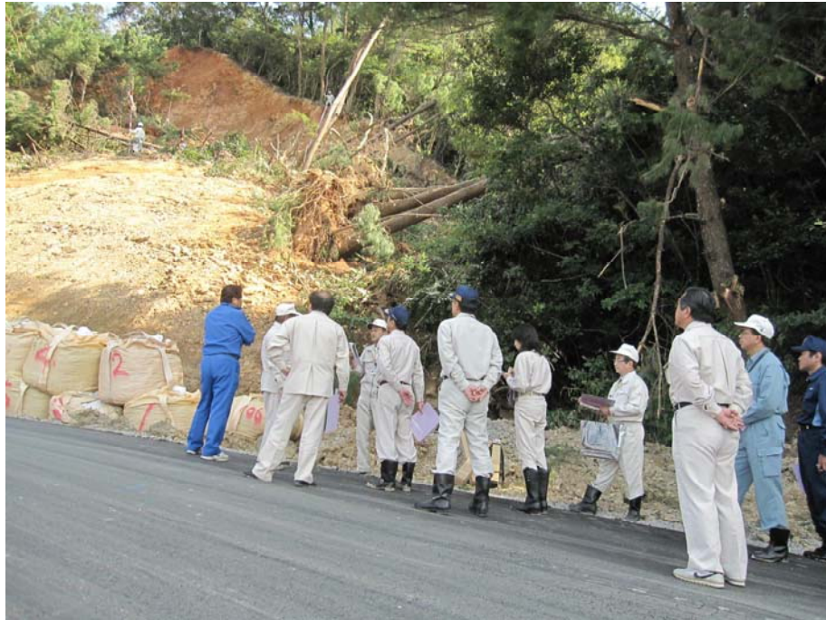
奄美市知名瀬の大規模崩落箇所の調査
