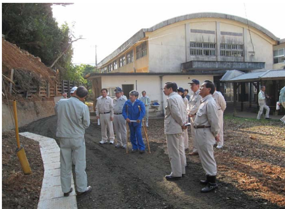
奄美市住用町の斜面崩落箇所の調査
