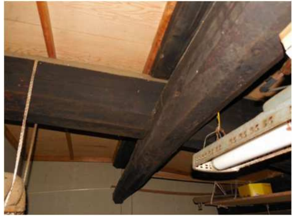
写真 13 構造材（梁・桁）の古材使用事例
