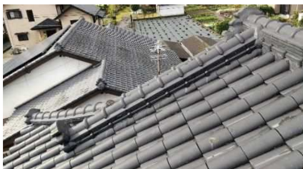
写真 9 勾配屋根の和瓦葺き
