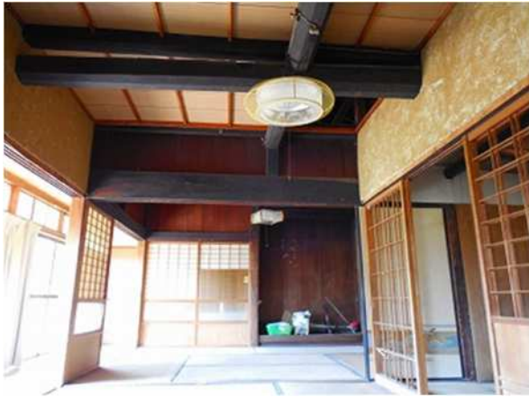
写真 13 構造材（梁・桁）の古材使用事例
