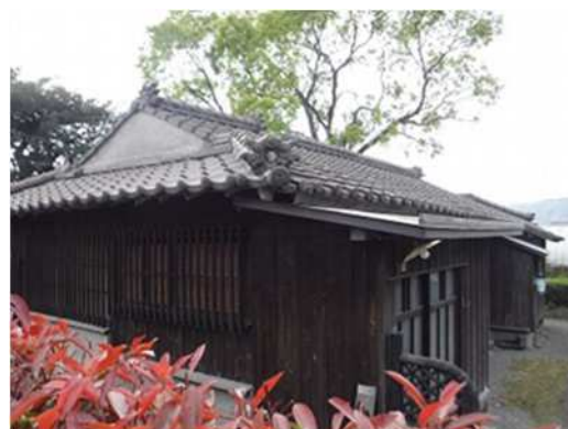
写真 10 下屋 (玄関) の金属板葺き
