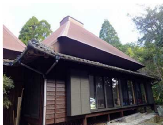
写真 12 既存屋根 (茅葺) の金属板葺
