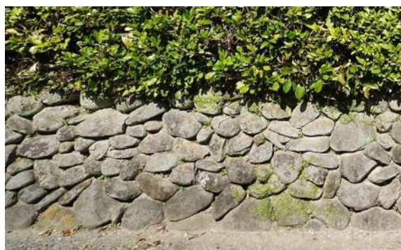
写真 17 野石積みの石垣
