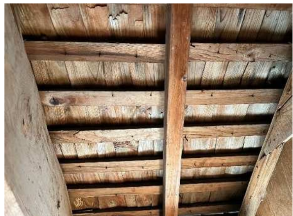
写真6 平木張りの材料および施工事例
