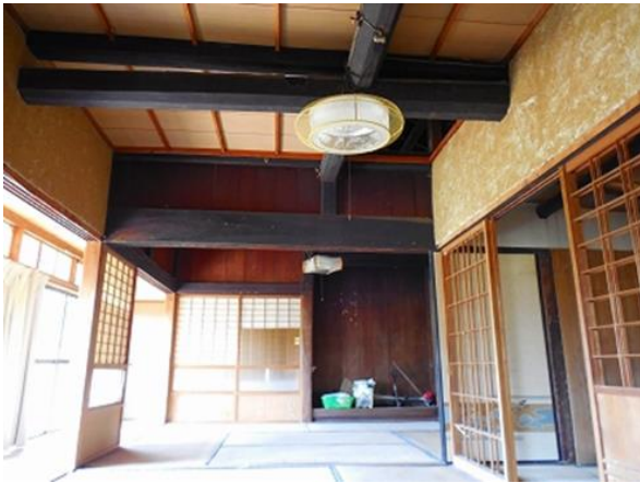
写真 13 構造材（梁・桁）の古材使用事例
