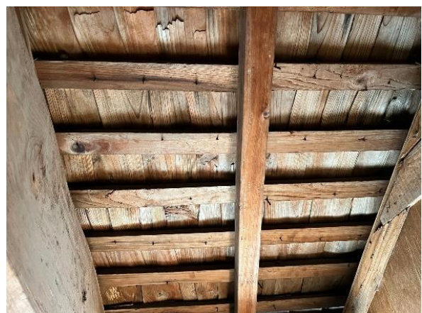
写真6 平木張りの材料および施工事例
