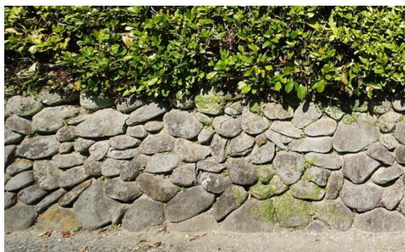
写真 17 野石積みの石垣
