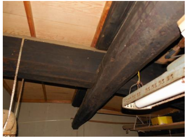
写真 13 構造材（梁・桁）の古材使用事例
