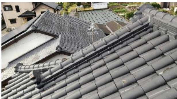
写真 9 勾配屋根の和瓦葺き
