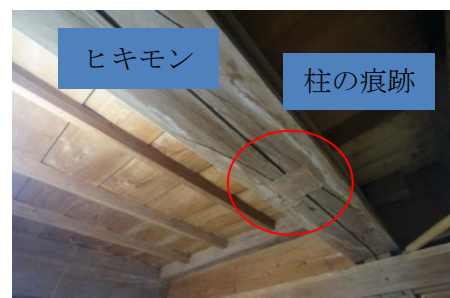
写真1 使いまわしたヒキモンに残る柱の痕跡
