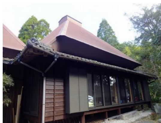
写真 12 既存屋根 (茅葺) の金属板葺
