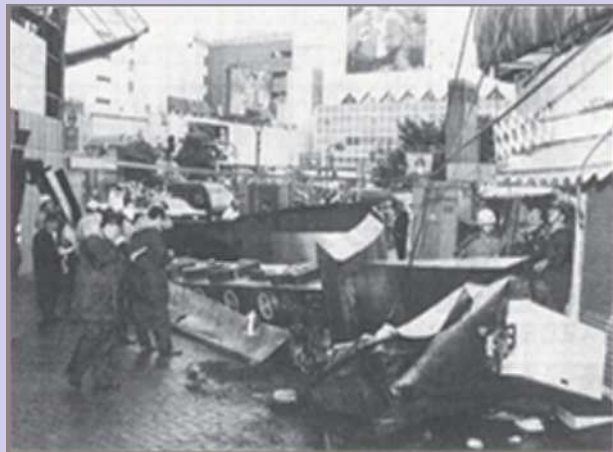
台風で落下した時の様子
