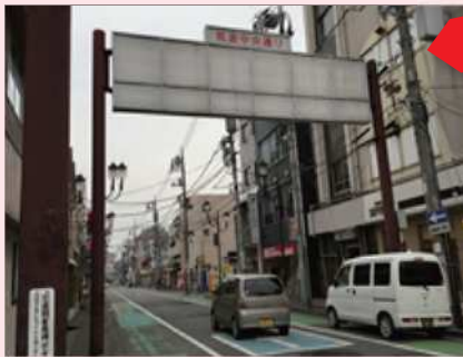
撤去されずに残されたアーチ看板
