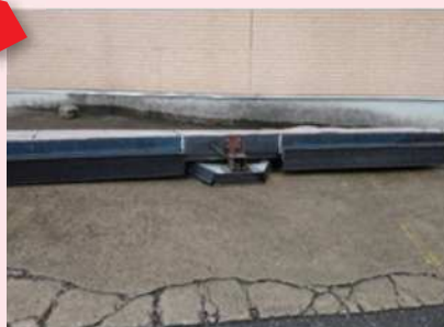
落下した欄間看板
