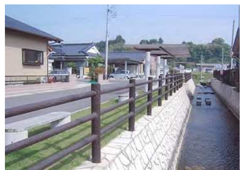
水路改修も同時に実施
