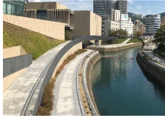
写真 6-33 スロープの設置
