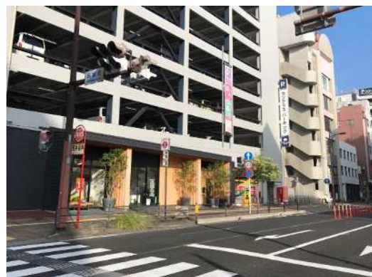
写真 6-22 1階部分を工夫した例
