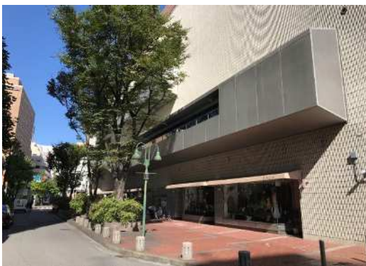
写真 6-15 単調な壁とならない工夫の例
