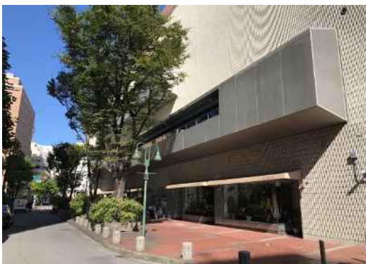
写真 6-15 単調な壁とならない工夫の例
