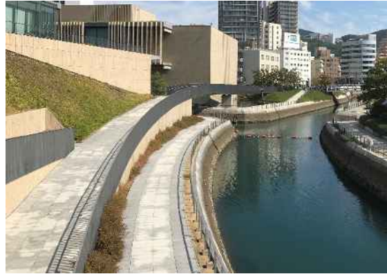
写真 6-33 スロープの設置
