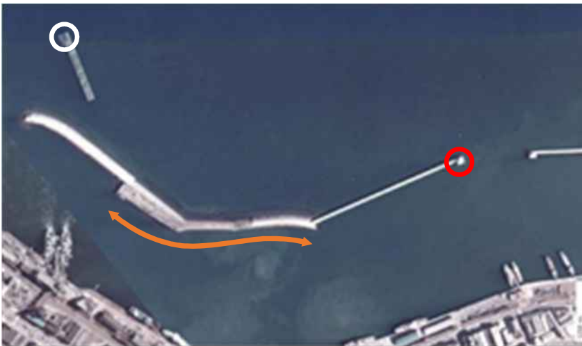
写真 6-9 1974(昭和 49)年 ～1978(昭和 53)年 頃の鹿兒島港
