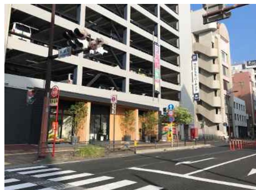
写真 6-22 1階部分を工夫した例
