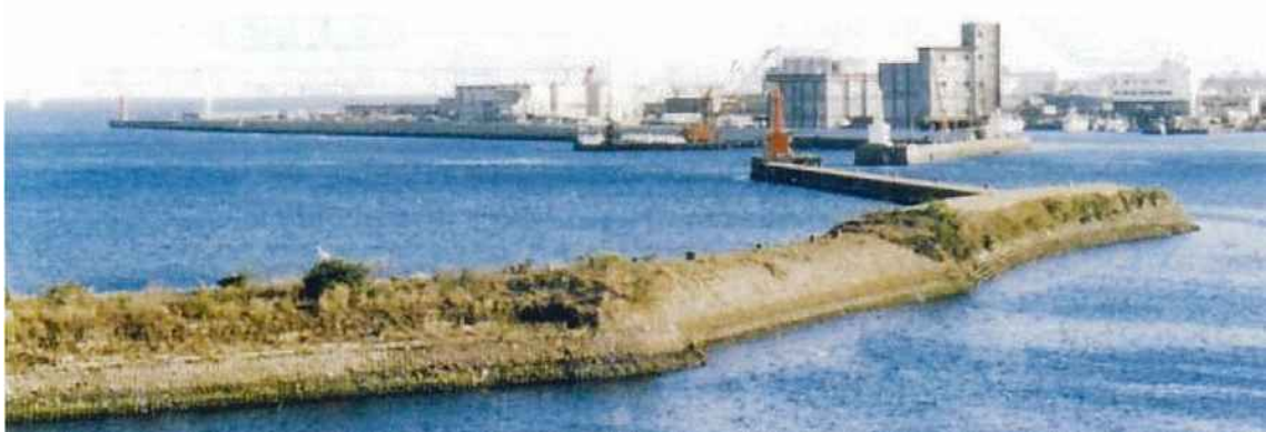
写真 2-4 1982(昭和 57)年頃の防波堤(新波止, 遮断防波堤, 一丁台場)と赤灯台(鹿児島旧港北防波堤灯台)
