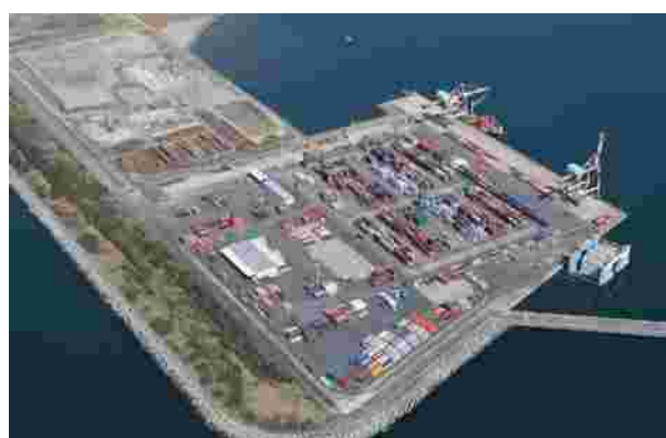
コンテナターミナルの耐震化
