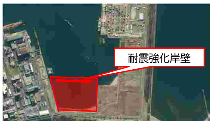
バルク岸壁（耐震強化岸壁）の整備
