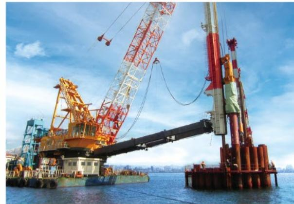
油圧ハンマを使用し、導枠に沿って『鋼管矢板』を海底地盤に打ち込みます。鋼管矢板は橋脚1基当たり24本を使用し、円筒状に打ち込みます。これを『鋼管矢板井筒』と言います。
