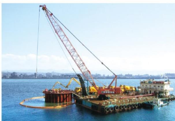
井筒内掘削が完了したら、井筒内の底から水が湧き出てくるのを塞ぐ蓋の役割を果たす底版コンクリートを打設します。その後、井筒内の海水を全て排水し、海水平より下でも地上と同じ作業環境をつくります。
