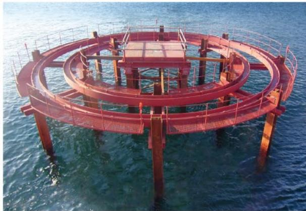
橋脚を支える基礎となる『鋼管矢板』を海底地盤に鉛直に打ち込むための定規の役割を果たす導航・導枠を設置します。
