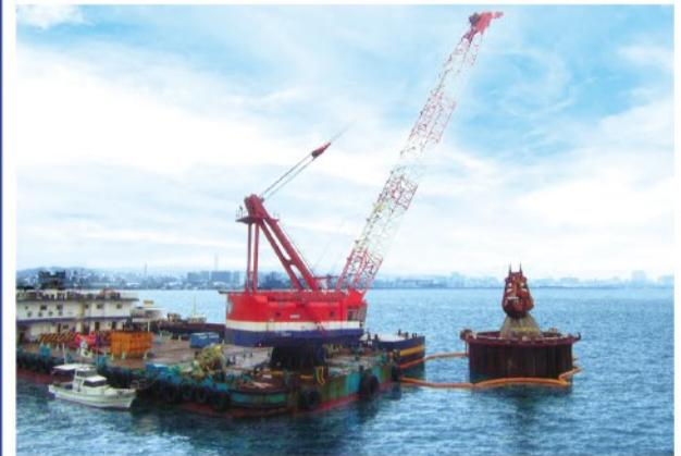
橋脚は海底面よりも低い位置に設置するため、『鋼管矢板井筒』の中の海底を掘り下げます。掘り出された土砂は所定の場所へ適切に処分します。
