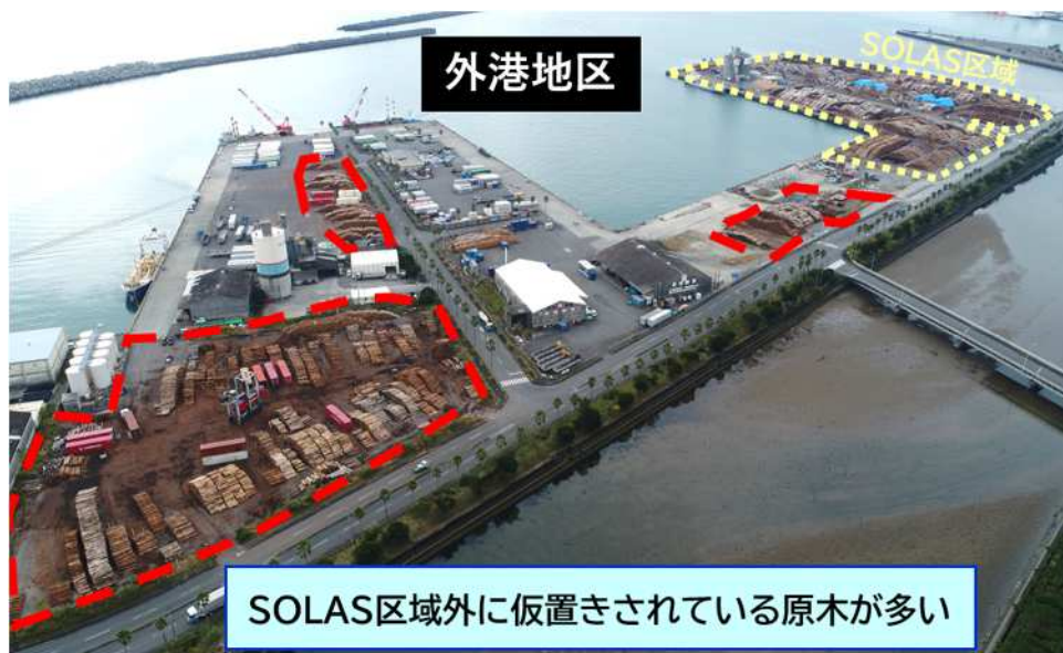
図 5-6 SOLAS 区域外への原木仮置きの状況
