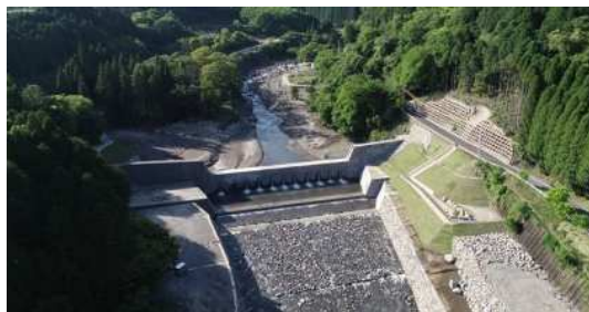
霧島川10号堰堤 (H30.2月完成)
