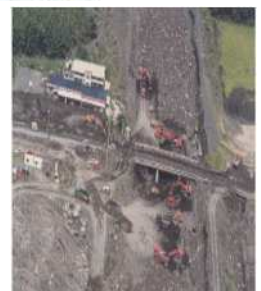
除石による砂防施設の機能確保 (野尻川)
