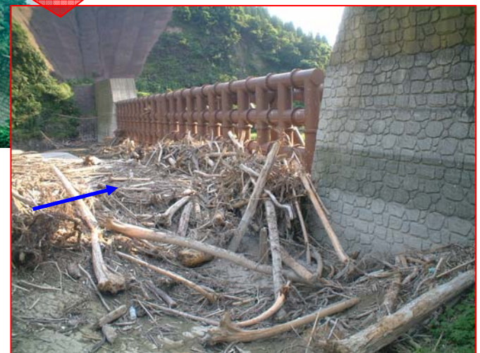
時期出水に備えていたため、 今年の大雨でも土砂や流木を捕捉できた
