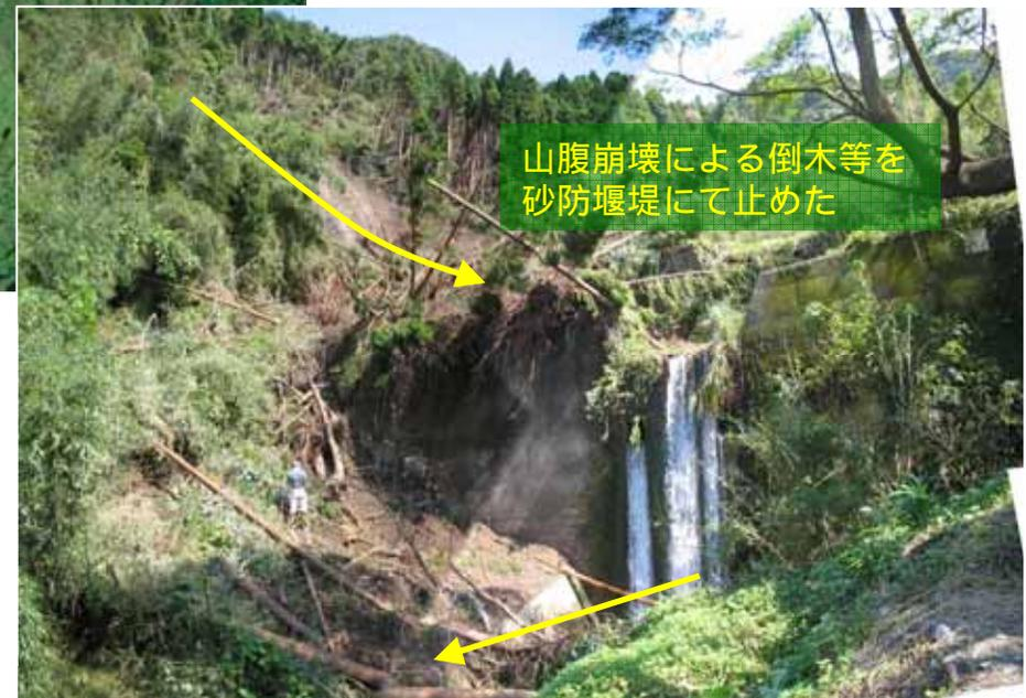
平成16年9月の台風21号により、磯脇川支川にて山腹崩壊が発生したが、砂防堰堤にて倒木等を捕捉し、下流保全対象への流出及び土石流の発生を未然に防ぐことが出来た。
