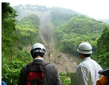
現地調査(根占山本地区)
