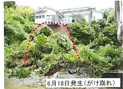
①【上寺下1地区】薩摩郡さつま町広瀬地内 6月18日発生(がけ崩れ)
