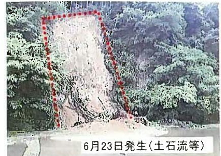
②【杵比野川】曾於市財部町杵比野地内 6月23日発生(土石流等)
