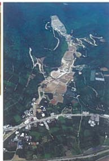
工事完了後の針原地区
