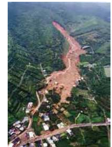
写真-5 平成9年針原川被害状況
