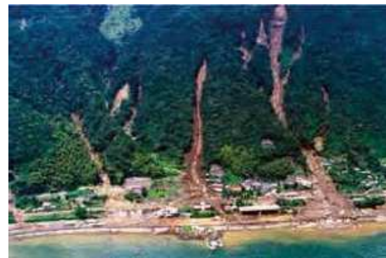
写真-2 平成5年竜ヶ水地区被害状況
