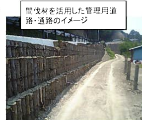
間伐材を活用した管理用道路・通路のイメージ
