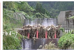
流木止め施設による流木捕捉工
