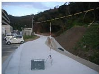
工事名: 総合流域防災(砂防)工事 (厚瀬川(2)工区) 工事箇所: 大島郡瀬戸内町厚瀬地区
