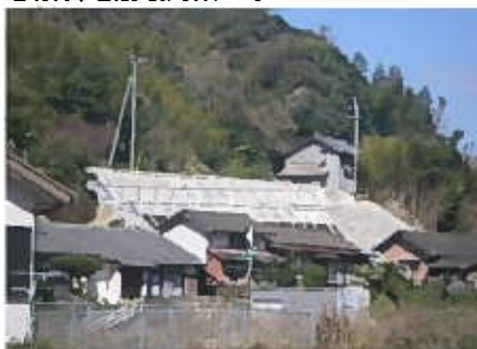
工事名: 急傾斜地崩壊対策工事 (仲仁田地区) 工事箇所: 阿久根市仲仁田地区
