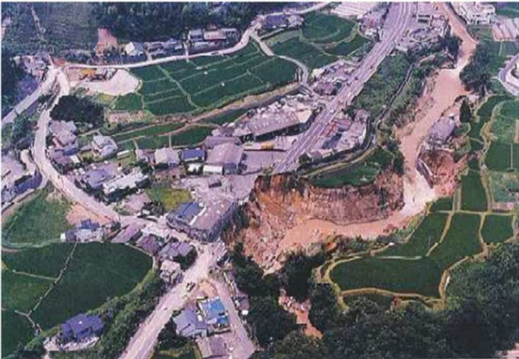
平成5年8. 6豪雨による甲突川（鹿児島市小山田町名越地区）の被害
