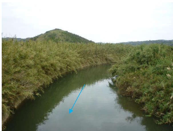
写真2-2 現況河川の状況 （1/575 湊川橋より上流）
