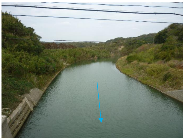
写真2-1 現況河川の状況 （0/585 かざもと橋より上流）
