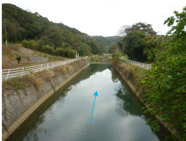
写真2-4 現況河川の状況 （4/320 西俣橋より下流）
