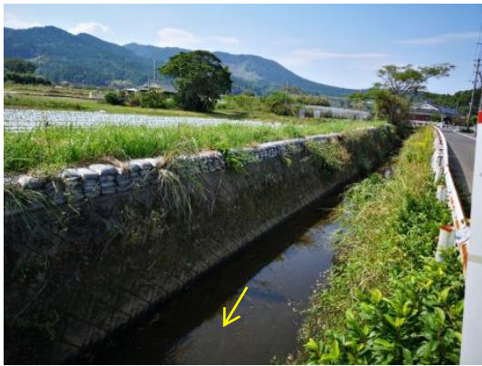
写真 2-7 3k510 付近 (土のうを 積みあげている) (未改修区間)
