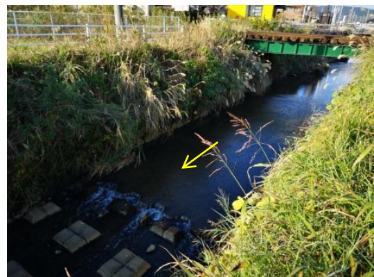
写真 2-4 JR 鉄道橋（2k200 付近）下流より 上流を望む（未改修区間）
