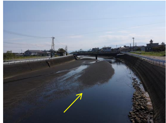
写真 2-11 湯ノ郷橋より下流を望む (干潮時に干潟が広がっている)
