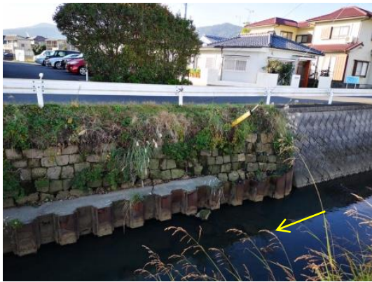
写真 2-5 二反田川河川敷堤防跡(2k300 付近) (未改修区間)
