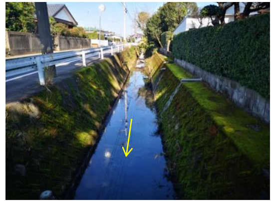
写真 2-8 中福良橋 (3k883 付近) より 上流を望む (未改修区間)
