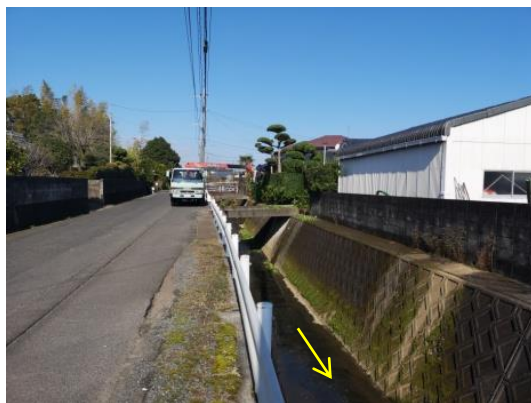
写真 2-9 4k040 付近より上流を望む (未改修区間)
