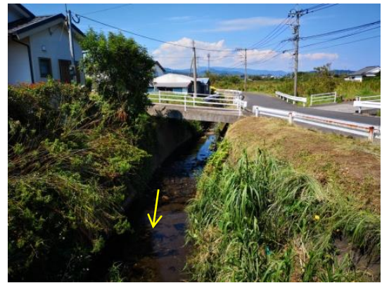
写真 2-6 河原橋 (2k900 付近) より 上流を望む (未改修区間)
