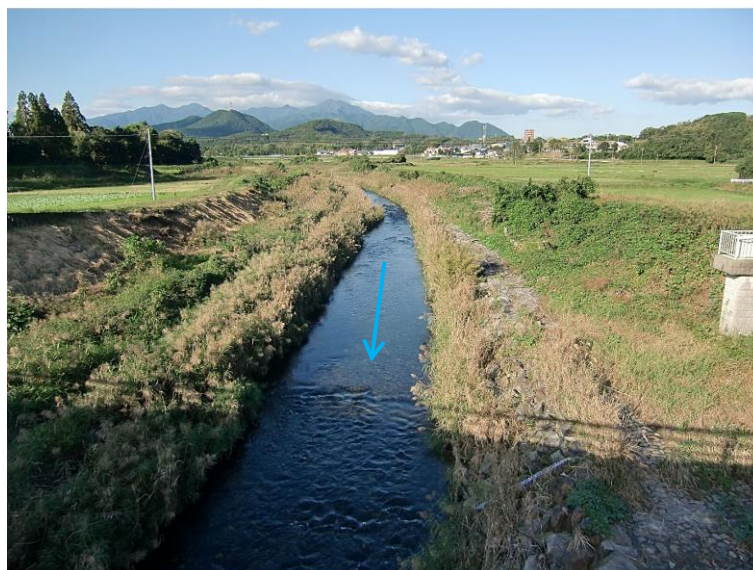
写真2-2 3.85km大津橋上流（年超過確率1/10改修区間）
