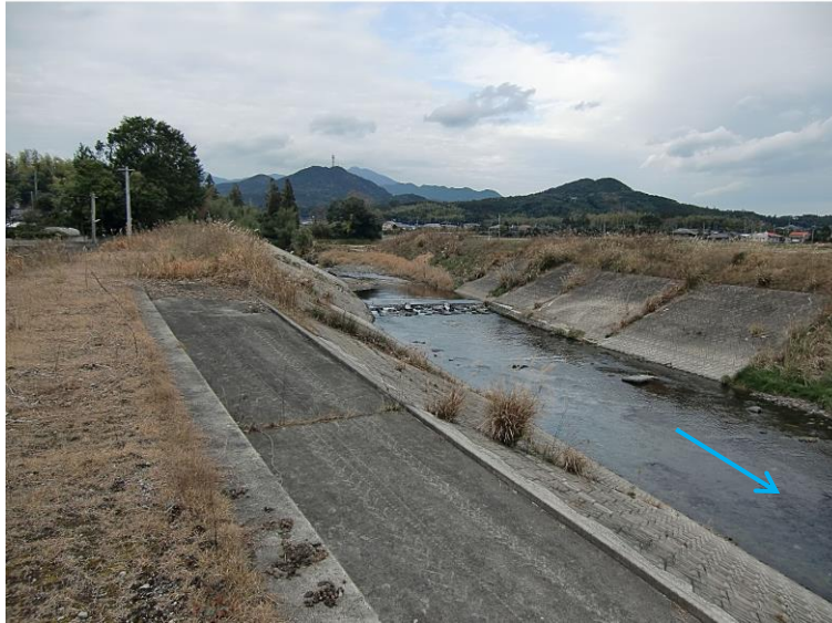
写真2-3 5.8km 付近改修区間上流端（年超過確率 1/10 改修区間）
