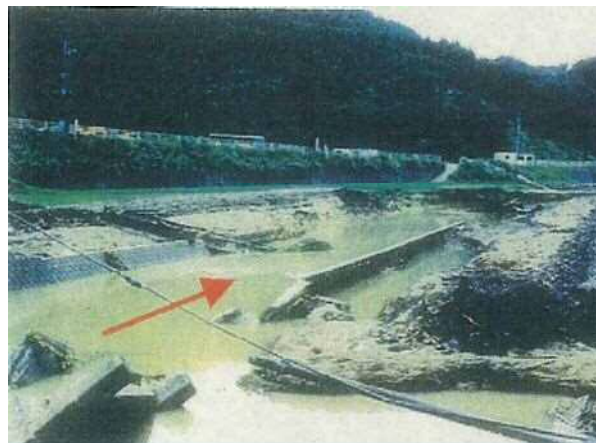
榕城橋下流護岸崩壊(3k350付近)
