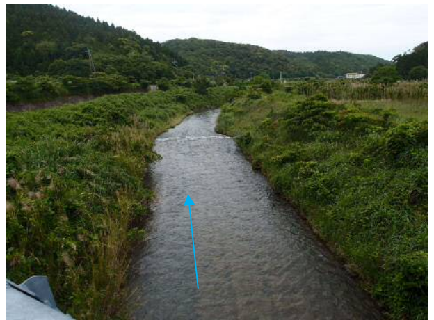
写真 2 - 2 現況河川の状況 (3k365 榕城橋より下流)
