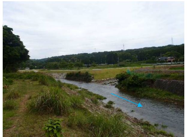
写真 2 - 4 現況河川の状況 (7/200 愛蔵川合流点)
