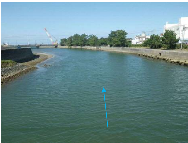
写真 2 - 1 現況河川の状況 (0k278 天神橋より下流)
