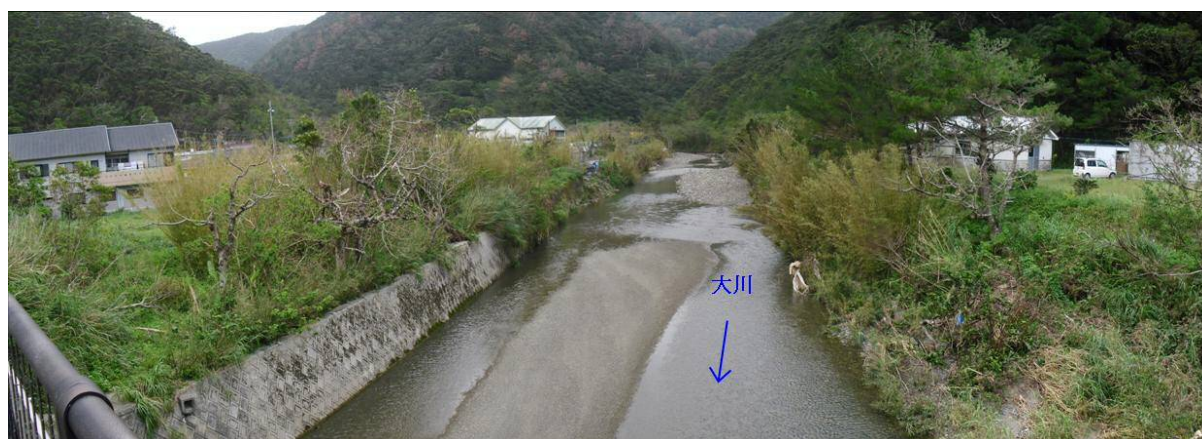
大川現況河道（3/900 付近）
