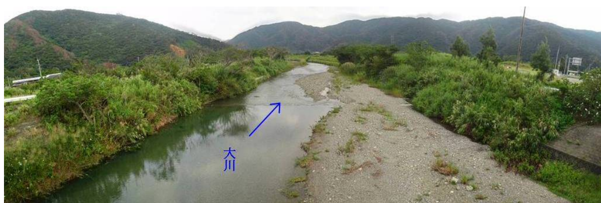
大川現況河道（2/500 付近）
