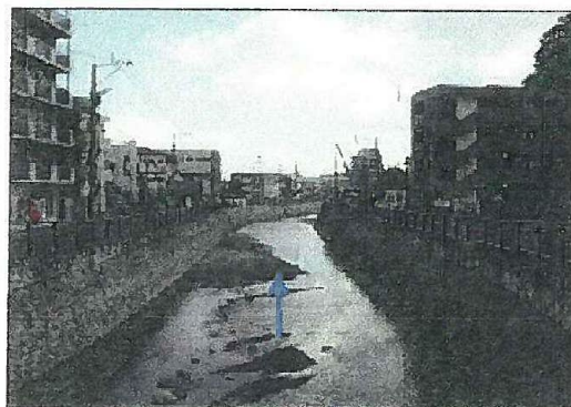
2k000 付近(墓地入口橋下流)の現況
