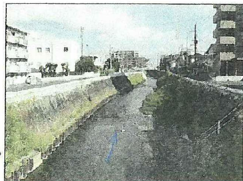
4k000 付近(徳重橋下流)の現況
