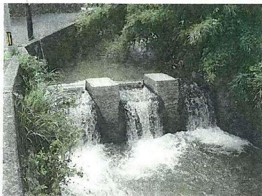
← 長井堰(8k631) (取水口 右岸)
