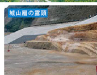
ダムの基礎岩盤である城山麓が出現しました。当該箇所では護岸を設置せずに城山麓を露出させたまま残しました。
