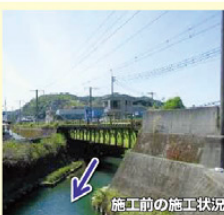
施工前の施工状況
