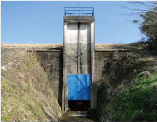
樋門第2樋門 (川内川水系樋門川)
