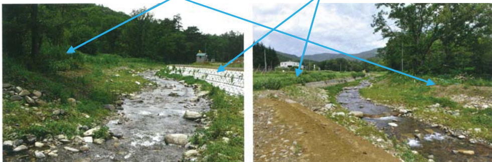
山付部は河岸防護を行う必要性が低いと判断し切土のみにした事例(元町川:岩手県)
