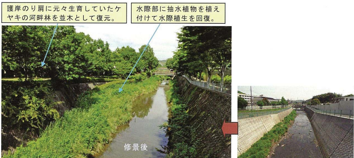
河道を修景整備した事例：水際の植生回復と河畔林の配置（いたち川：神奈川県）
