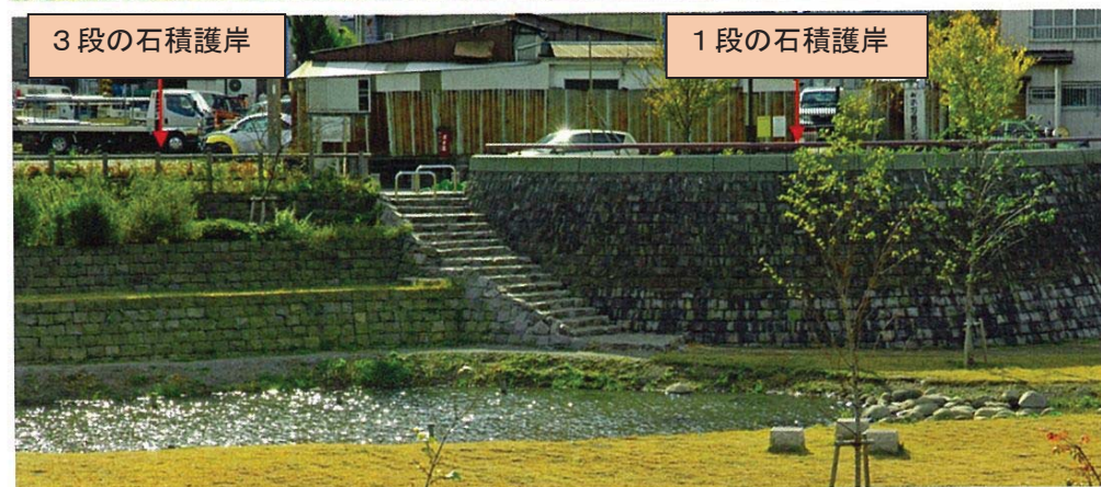
護岸に小段を付け護岸の圧迫感を緩和した事例（和泉川：神奈川県）
