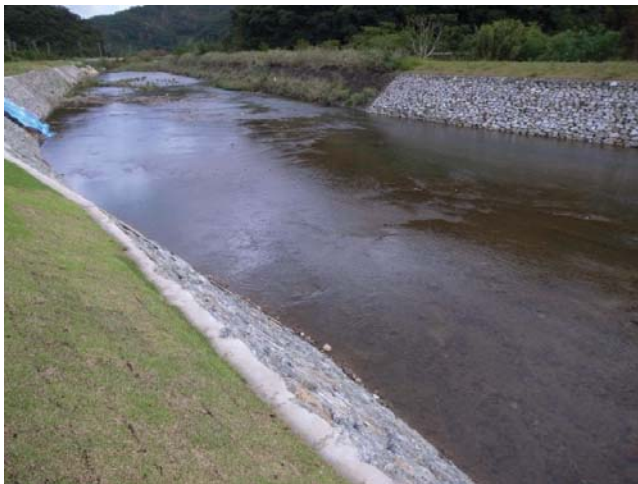
～河川改修により瀬・淵・水際部が失われた事例～
