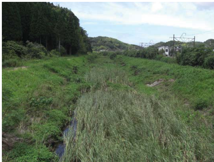
～みお筋が固定化され、川床に植物が繁殖している事例～ (二級河川草道川：鹿児島県薩摩川内市)
