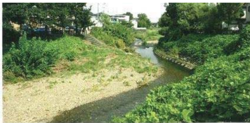
蛇行を残した区間（境川：神奈川県） （蛇行を残し、川幅を広く確保したことによって水深や流速に変化が見られる多様な河道形状が形成されている）
