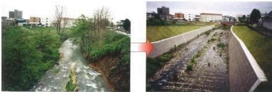
改修前後の河岸の状況の違い
