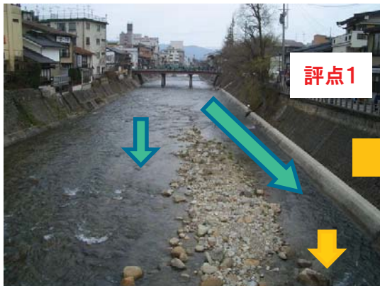
両岸とも変化がなく単調である
