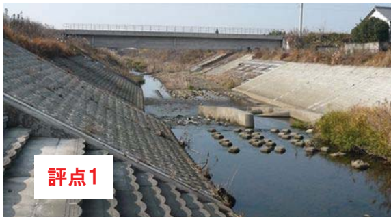
両岸とも水際が隙間のない護岸で固められている/岩壁である
