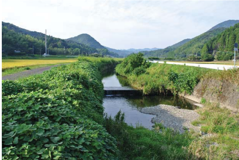
～河床の安定性と連続性が確保されていない事例～ (二級河川草道川：鹿児島県薩摩川内市)
